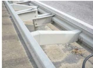
図1・写真1 高低差のある中央分離帯に設置するGrm
