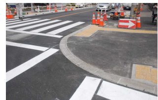
写真-2 交差点部の導水ブロック施工
