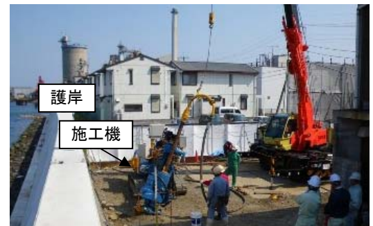
写真-1 試験施工状況
