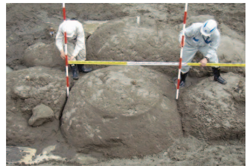
写真-1 現場実験での改良体試掘状況
