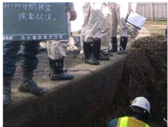
写真2 タンク周辺部の掘削調査状況
