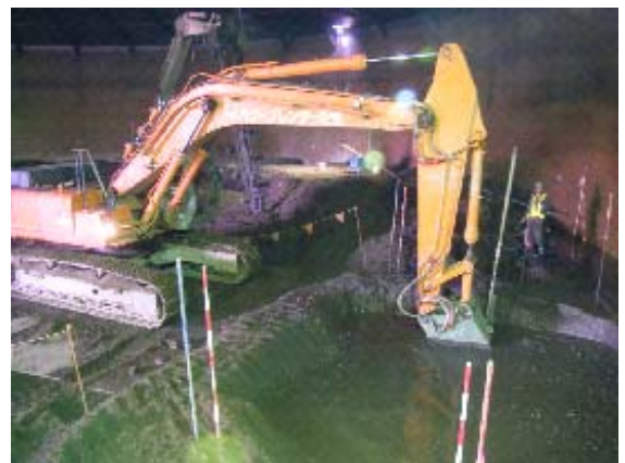
写真1 流体状の水混合土(事前混合)
