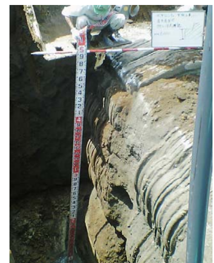
写真-5 改良体の出来形
