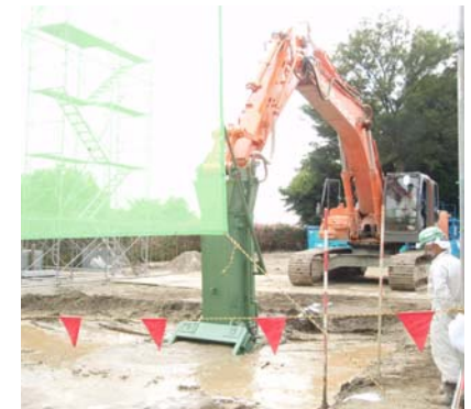
写真-3 水平トレンチャー施工状況
