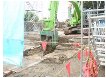
写真-2 鉛直トレンチャー施工状況
