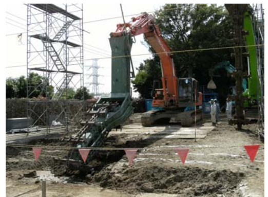
写真-2 水平トレンチャー
