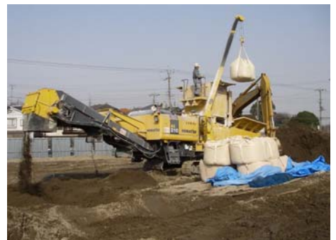
写真-1 移動式土質改良機によるセメント混合状況
