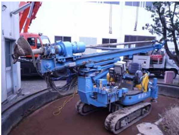
写真-2 施工機の全体像
