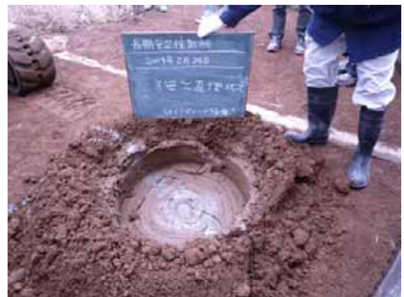
写真-4 施工直後状況
