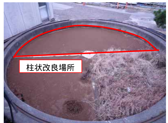
写真-1 施工現場状況
