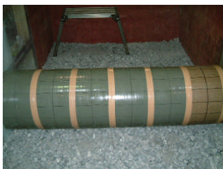
写真 1 供試管設置状況
