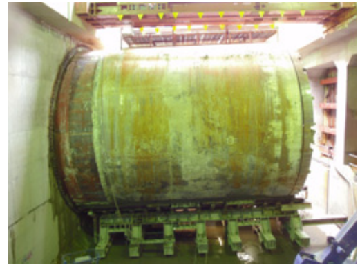
図5 上り線到達隔壁解体完了写真
