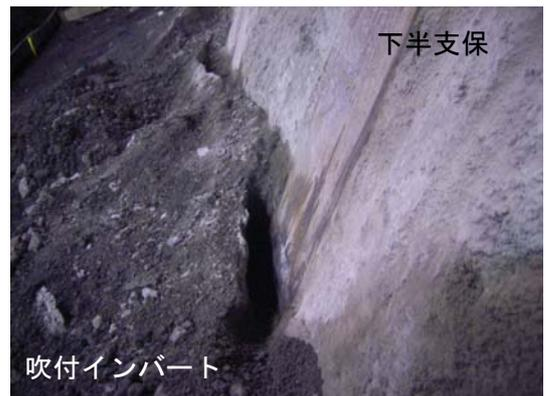
写真-1 吹付インバートの変状
