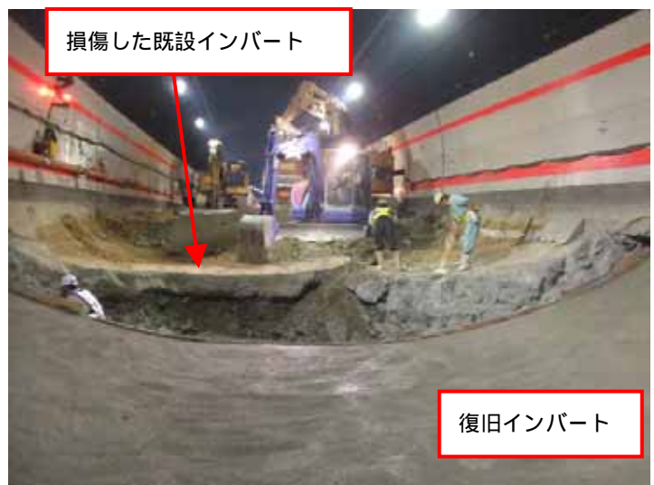
写真 - 2 インバート対策状況
