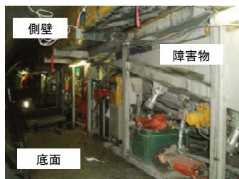
写真-2 坑内状況 (A トンネル)
