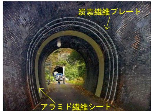
図 5 現地施工確認試験
