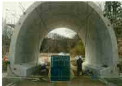
写真-1 モジュラーチ据え付け状況
