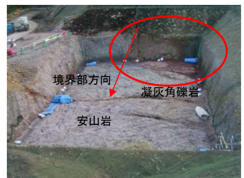
写真-1 床付け面
