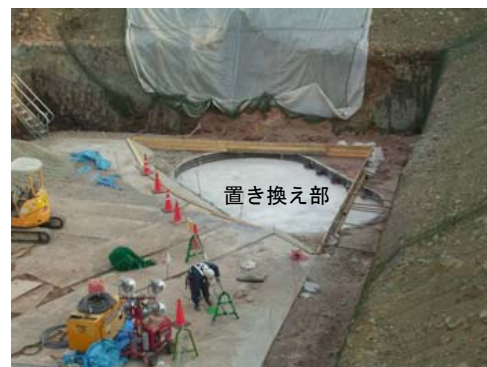
写真-2 置き換え対策工
