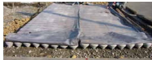
写真 2-2 地盤補強用マット施工状況
