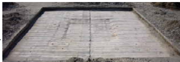
写真 5-1 地盤補強用マット状況(载荷試験後)
