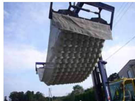
写真 2-1 地盤補強用マット
