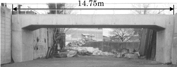
写真 1 GRS 一体橋梁
