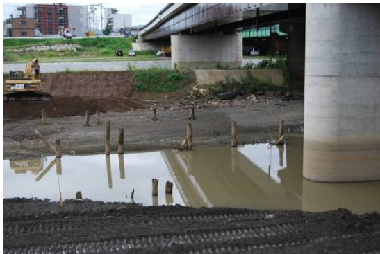
写真-1 木田橋下流側の木杭
