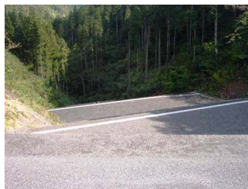
写真1 残土処分場の現況
