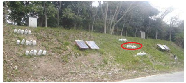
写真-3 システムの現地設置状況
