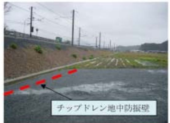
写真-1 現地試験施工状況
