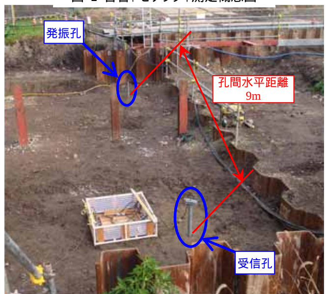
写真-1 現場測定状況
