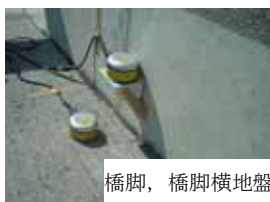
写真 1 加速度計設置状況
