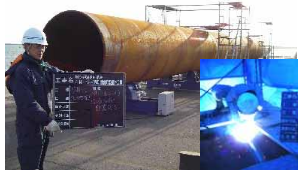
圖-4 鋼管杭橫繼溶接
