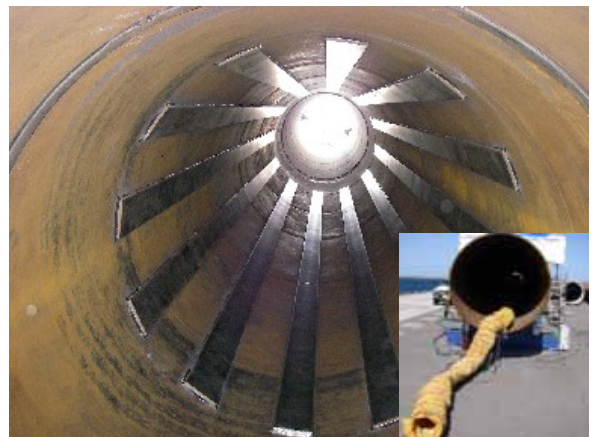
図-5 鋼板の溶接
