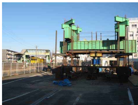
図4 載荷試験状況
