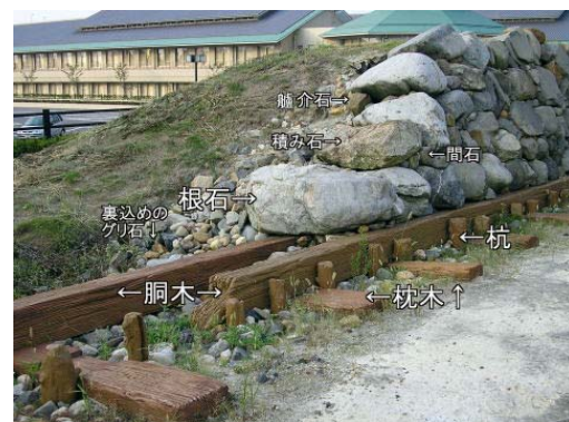
写真-1 杭付き胴木基礎工法 1)
