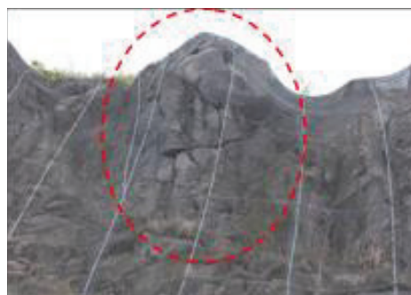
写真-1 実岩盤斜面
