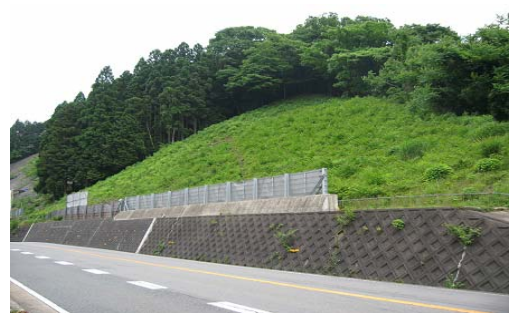
図-6 B 地区現場写真
