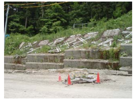
写真-2 受圧板の移動状況
