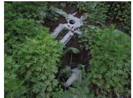
写真-4 引張材の引き込み状況
