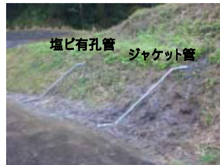
写真-4 試験施工完了
