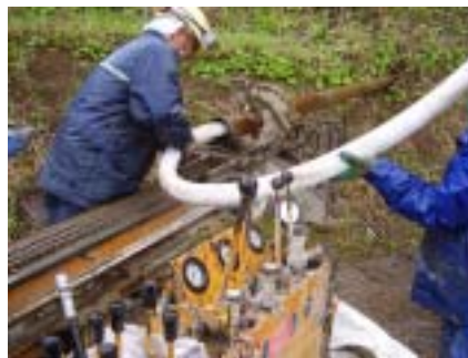
写真-3 ドレーン挿入状況
