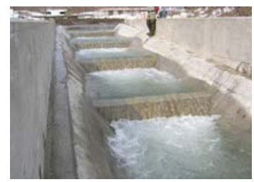
写真 2 原型の一例 ( i=1/10, m=1, S=30\text{cm}, h=50\text{cm} Q=0.292\text{m}^3/\text{s}, dc/s=0.4 )
