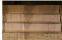
図 1-1 矩形断面階段式魚道
