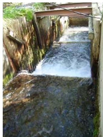
写真 1 最下流部の治山堰堤(第 1 床固工)に設置された折り返し魚道
