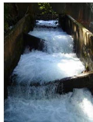
写真 2 最下流部から 2 番目の堰堤(第 2 床固工)に設置された折り返し魚道
