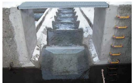
写真 6 流量制御のための隔壁増設
