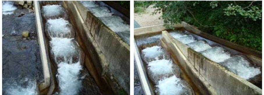
写真 4 第2床固工で改善された台形断面魚道(流量 0.38 m<sup>3</sup>/s 時)
