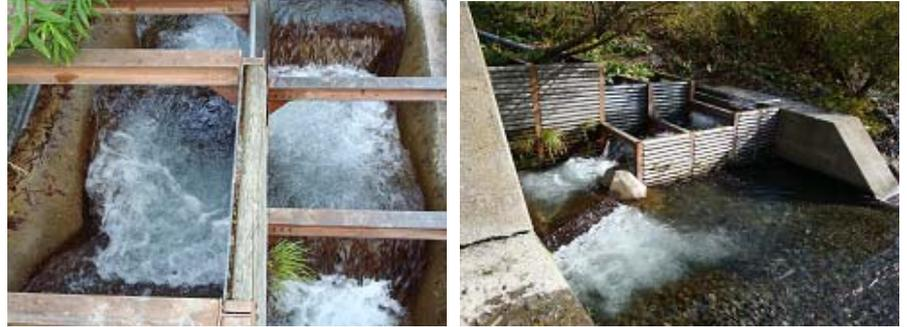
写真 3 第1床固工で改善された半台形断面魚道(流量 0.23m<sup>3</sup>/s 時)
