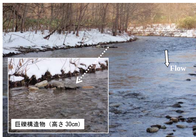
図-1 設置した巨礫構造物（護岸区間）
