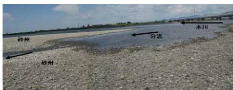
写真-1 調査地点分流部
