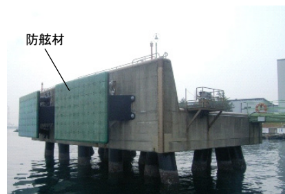
写真-1 接岸ドルフィン
