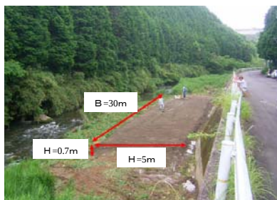
写真-1 未処理土の置き土状況
