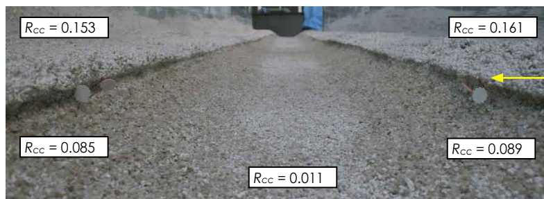
写真-1 浸食を受けた流路の状況：黄色の矢印位置が下流端から 3.4m 上流側の地点を表す。
