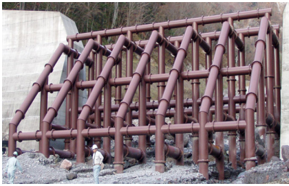
写真-1 鋼製砂防堰堤
