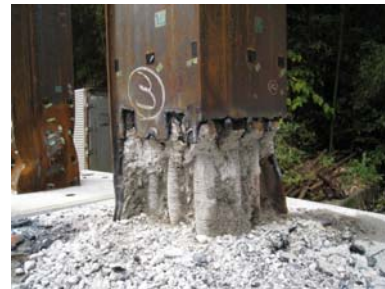
図5 No.1 試験体 基部内部状況
