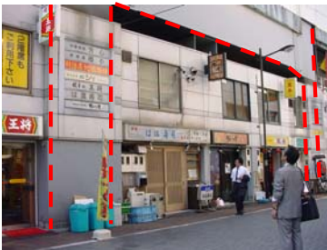
図 2 現況（--鋼ラーメン橋台）
