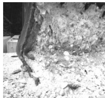
図-4 試験体内部の様子 (試験体 A)
