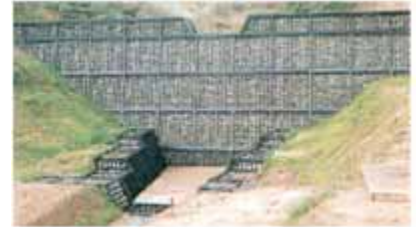
写真-1 鋼製枠砂防堰堤
