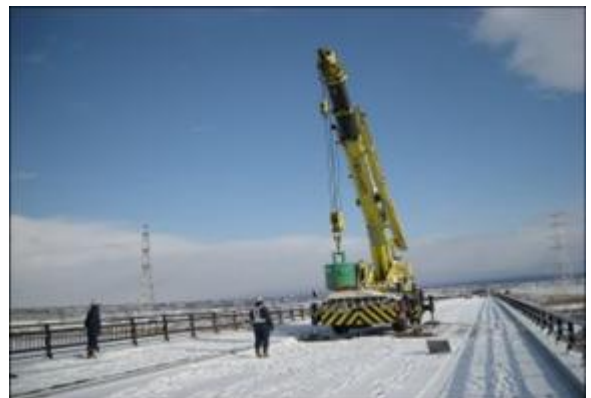
写真-1 クレーン加振状況
