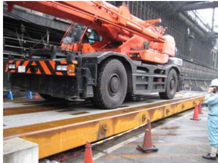
図-4 構造的な性能調査 車載荷状況
