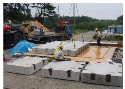
写真3 踏掛版吊り作業状況
