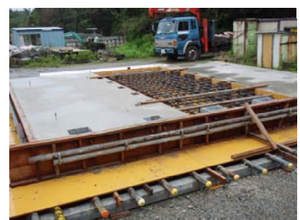
写真2 コンクリート打設方法
