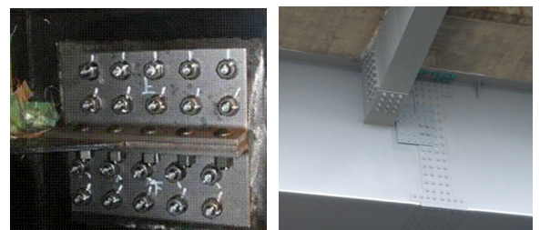
写真-4 対策後(左:2連目桁内面、右:3連目桁外面)
