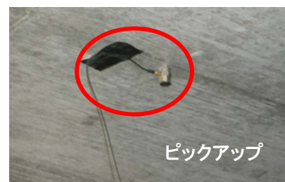
図1 ピックアップの設置
