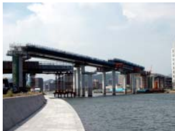
写真-1 側桁の横取り状況
